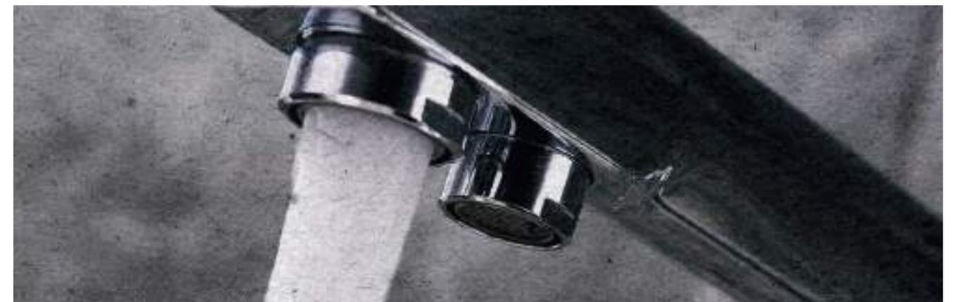
O arejador é um componente importante para um bom funcionamento de torneiras e misturadores, pois controla a vazão e o diâmetro do jato d'água e evita respingos. Projetado para reduzir a vazão de água e introduzindo bolhas de ar no fluxo da água, o que acaba produzindo um fluxo mais estável e com sensação de maior volume, mas com menor consumo, estimulando a economia.
